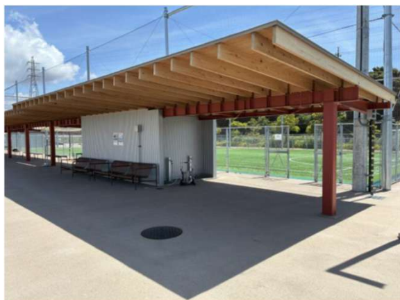
②多目的コートB前軒下スペース
